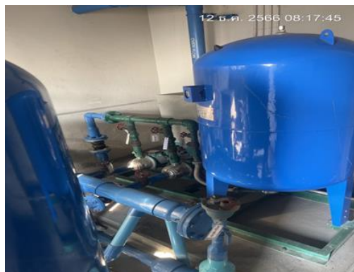
ภาพที่ 13 ตรวจสอบรอยรั่วของท่อจ่ายน้ำ
